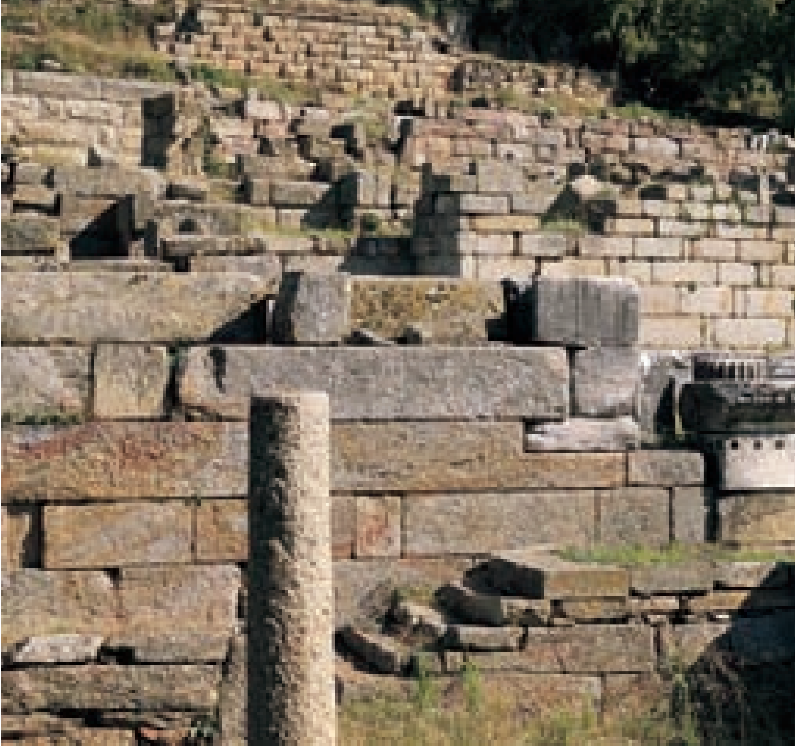
Teras duvarlarından görünüm. (yan sayfada) Andron A duvar, detay. / View from the Terrace Walls. (adjacent page) Wall from Andron A, detail. (foto/photo: T. Kutlu)
