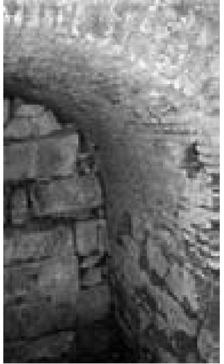
Güney Hamamı, yeraltı külhan yapısı tuğla beşik tonoz (sol en üstte ve sağda). Dört Apsisli Hamam, külhan bölümü (sol üstte). (yan sayfada) Dört Apsisli Hamam, değişik duvar teknikleri.
