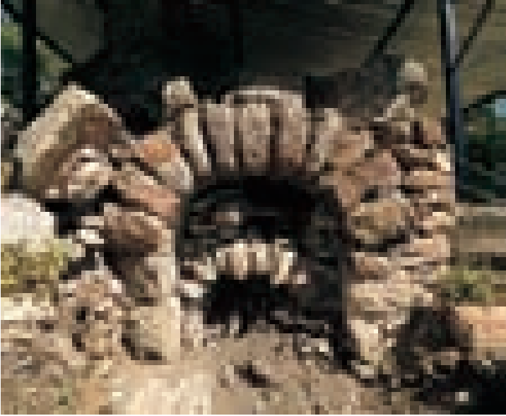
Güney Hamamı, yeraltı külhan yapısı tuğla beşik tonoz (sol en üstte ve sağda). Dört Apsisli Hamam, külhan bölümü (sol üstte). (yan sayfada) Dört Apsisli Hamam, değişik duvar teknikleri.
