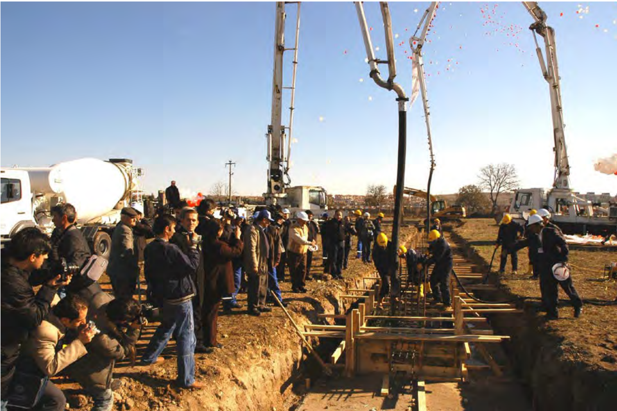
İpekyol Tekstil Fabrikası temel atma töreni
