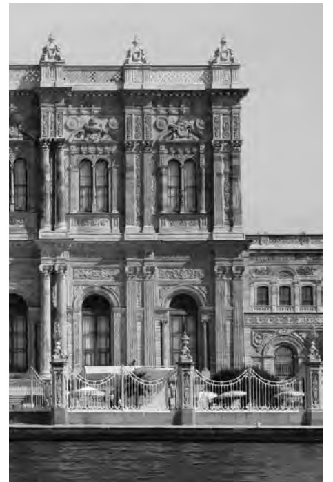
Dolmabahçe Sarayı Boğaz cephesinden detay
