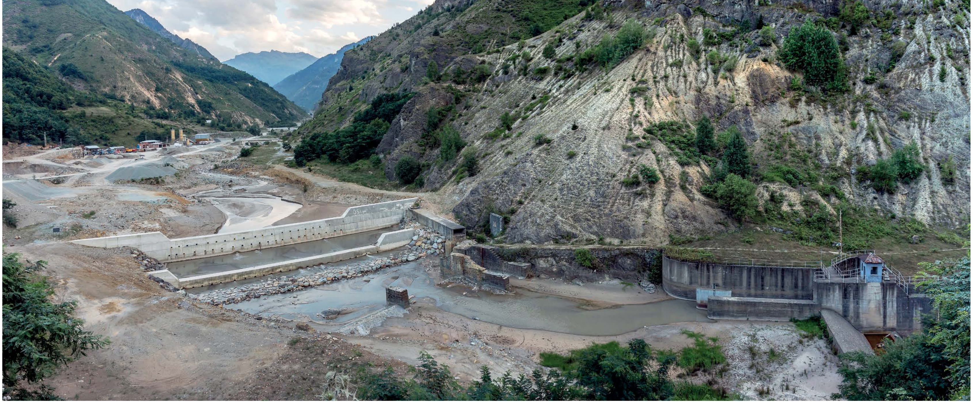
Artvin, Murgul'da hidroelektrik santrali
