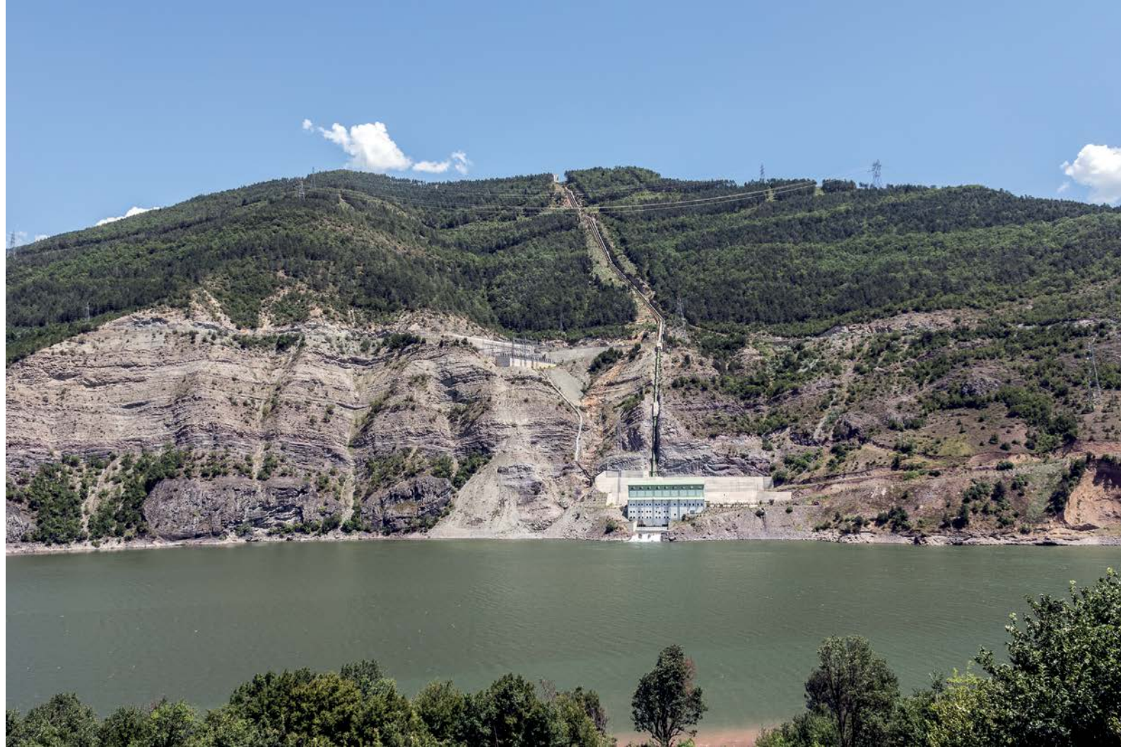
Artvin, Ormanlı'dan sonra, Sümbüllü-2 viyadüğünden önce, kanal tipi bir HES
