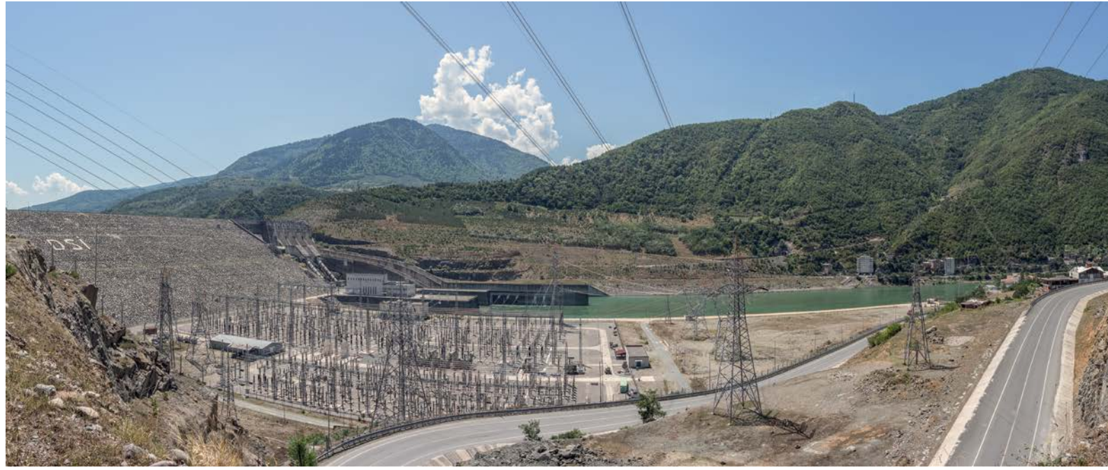
Borçka Barajı ve HES, Çoruh Nehri ile Murgul Çayı'nın birleşim yerinin yaklaşık 300 metre akışaşağısında, Borçka ilçesinin 2,5 km kaynağında ve Artvin ilinin 30 km kuzeybatısında bulunmaktadır.
