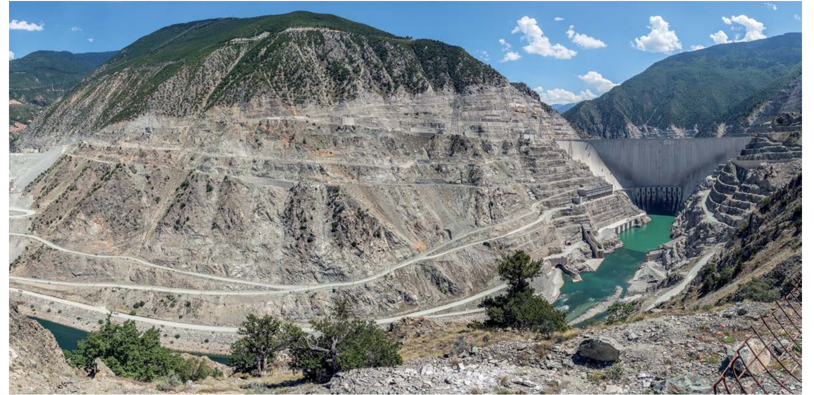
Deriner Barajı, Artvin'de, Çoruh Nehri üzerinde, enerji üretmek amacıyla 1998 yılında inşasına başlanmış bir barajdır. Sahip olduğu 249 metre gövde yüksekliği ile Türkiye' nin en yüksek, Dünya' nın 6. yüksek barajıdır. [Kaynak: Vikipedi]
