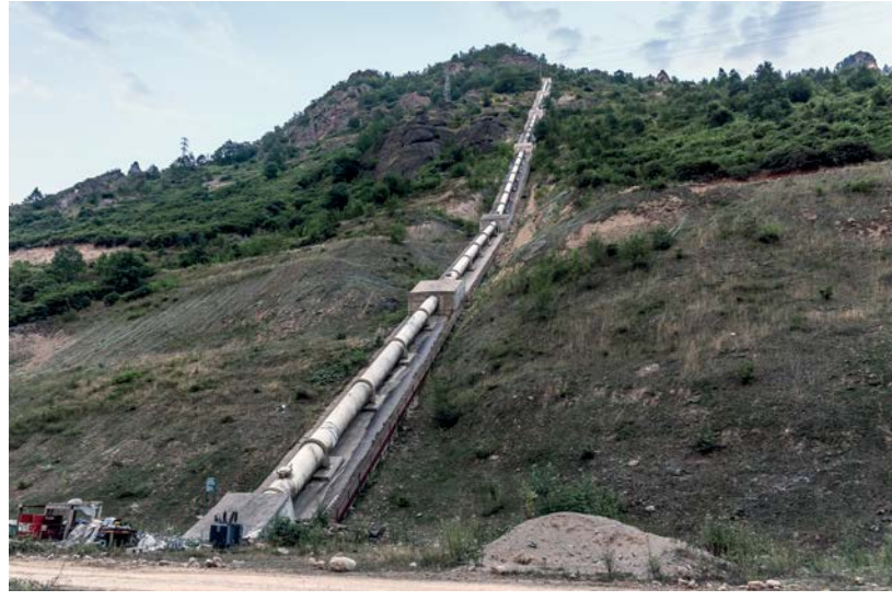
Artvin, Murgul'da kanal tipi bir hidroelektrik santrali
